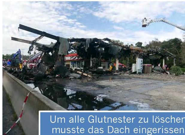
Um alle Glutnester zu löschen musste das Dach eingerissen werden
