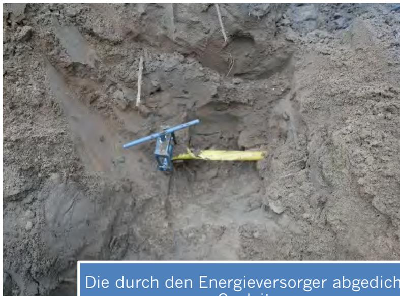
Die durch den Energieversorger abgedichtete Gasleitung
