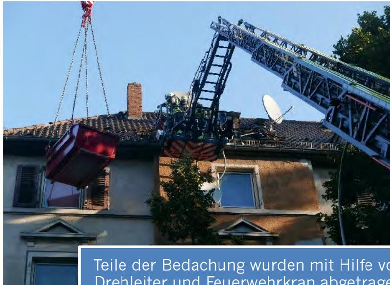
Teile der Bedachung wurden mit Hilfe von Drehleiter und Feuerwehrkran abgetragen
